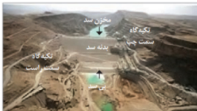
شکل ۴-۵. نمایی از بخش های مختلف یک سد
